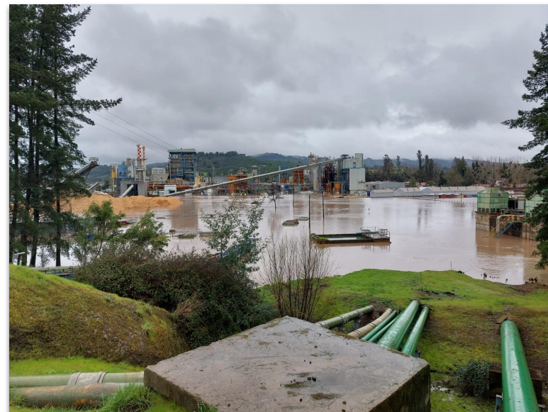
Planta de celulosa inundada en Licantén (fuente: El Desconcierto, 2023)
